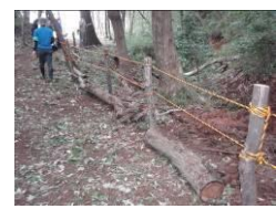
立派な柵が30m完成
